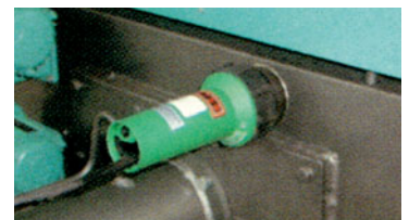
Zündautomatik - über ein zeitgesteuertes Zündgebläse werden die Brennstoffe automatisch gezündet. Die materialsparende Einrichtung regelt den Kessel von 0-100%.
